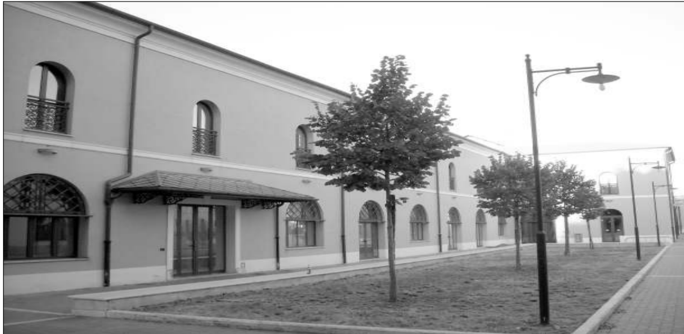
Uno degli edifici del complesso dell'ex Siri, destinato ad ospitare il polo museale ternano e la pinacoteca comunale
